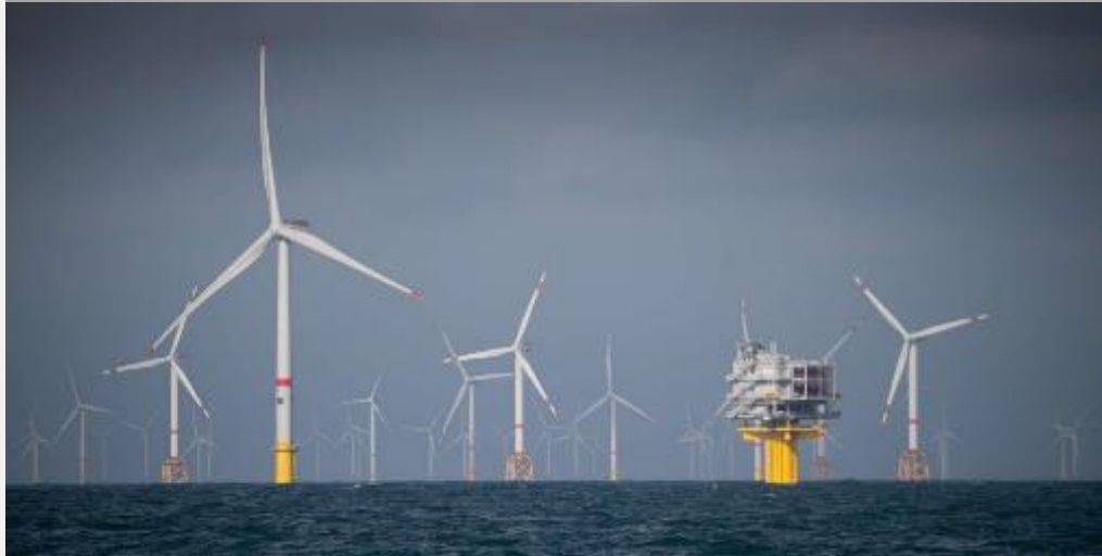
Ferme éolienne Offshore
